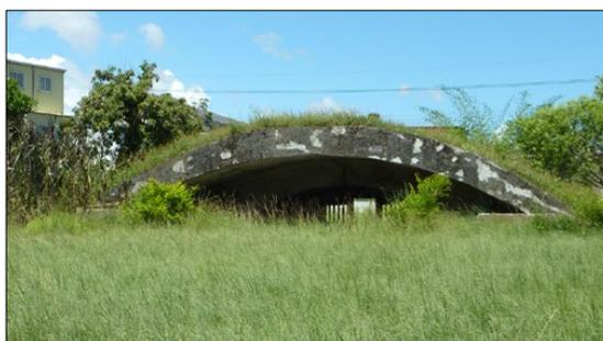
圖 2：進士里 2 號機堡，位於進士路農田中央，此飛機掩體屋身構造一樣為弧形窟窿式，正面未砌磚牆。
